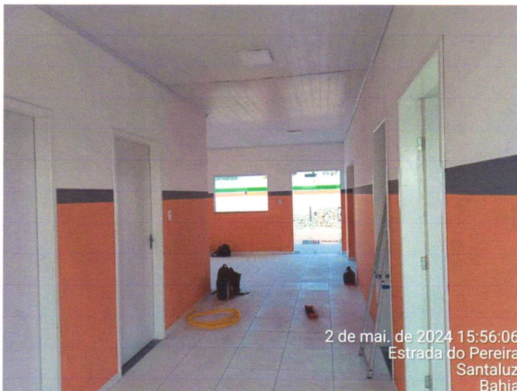
Foto 23 - KIT DE PORTA-PRONTA DE MADEIRA EM ACABAMENTO MELAMÍNICO BRANCO, FOLHA LEVE OU MÉDIA, 90X210, EXCLUSIVE FECHADURA, FIXAÇÃO COM PREENCHIMENTO TOTAL DE ESPUMA EXPANSIVA - FORNECIMENTO E INSTALAÇÃO. AF_12/2019
