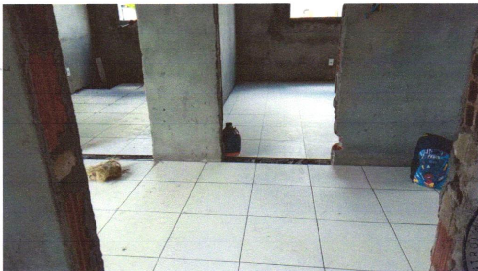
Foto 26 - REVESTIMENTO CERÂMICO PARA PISO COM PLACAS TIPO ESMALTADA EXTRA DE DIMENSÕES 45X45 CM APLICADA EM AMBIENTES DE ÁREA MAIOR QUE 10 M2. AF_06/2014
