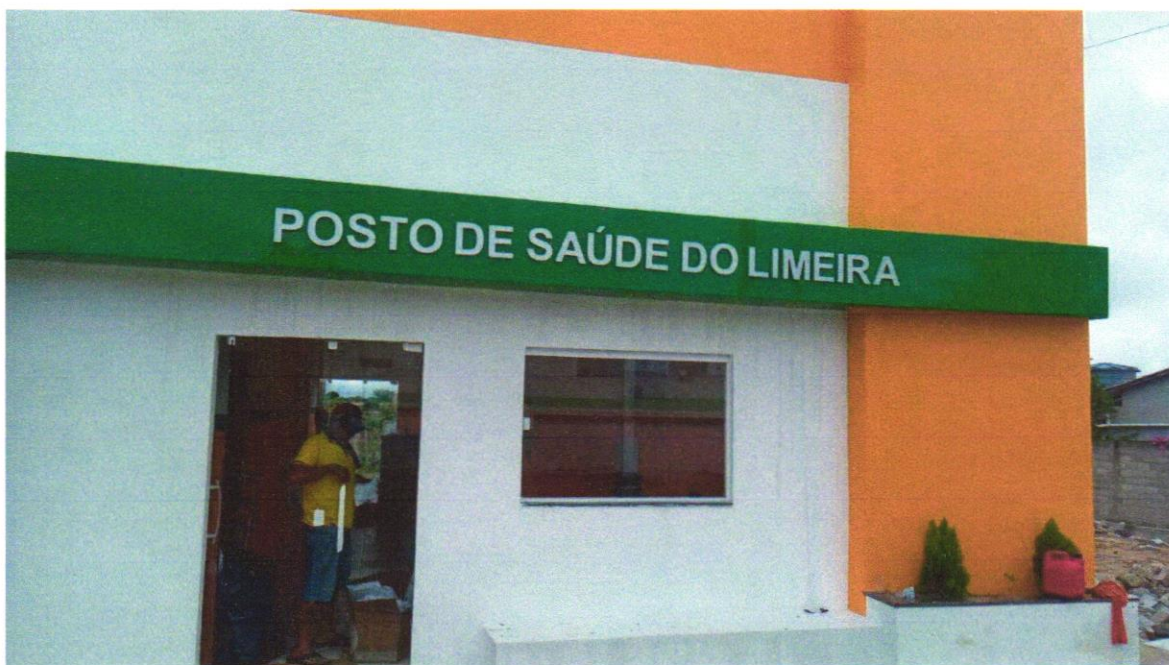
Foto 03 - Letra em alumínio 20 x 20cm - instalado
