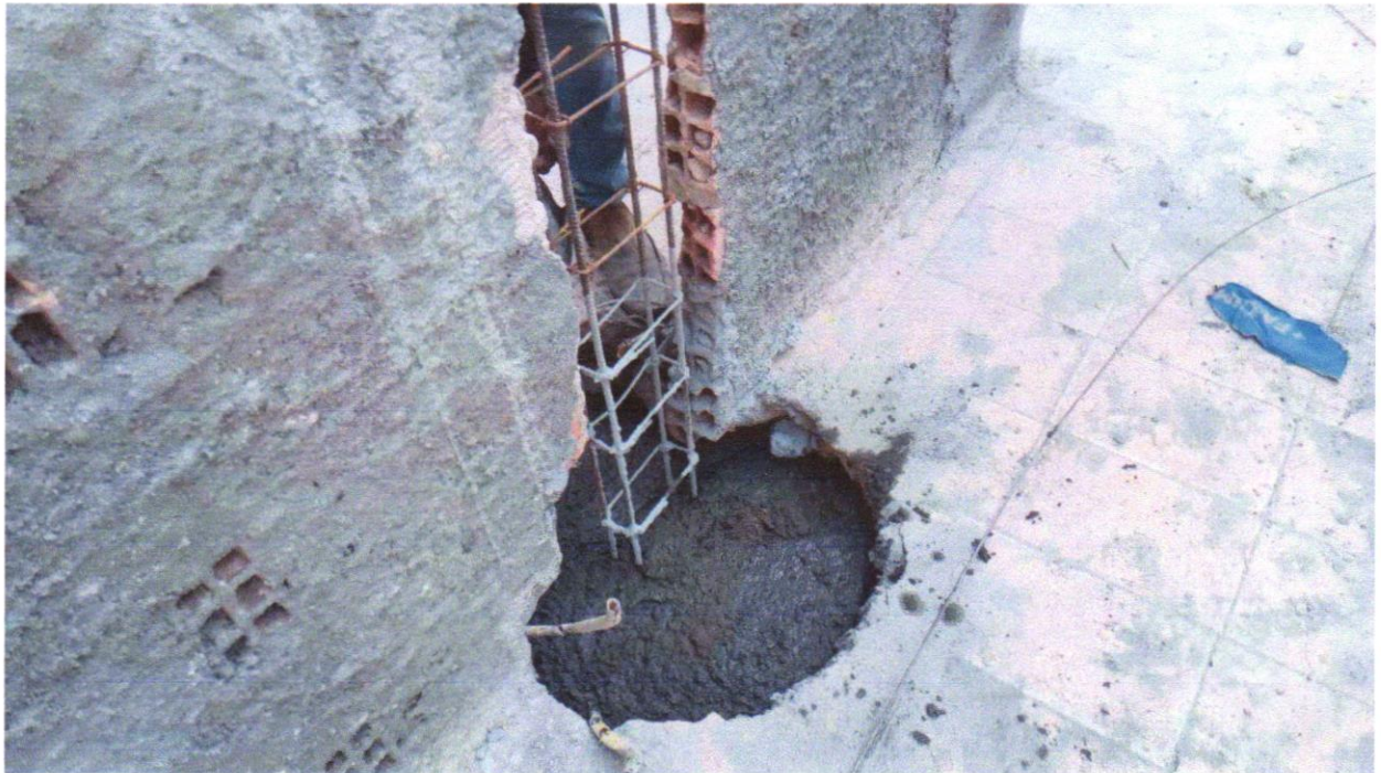
Foto 19 - (COMPOSIÇÃO REPRESENTATIVA) EXECUÇÃO DE ESTRUTURAS DE CONCRETO ARMADO, PARA EDIFICAÇÃO HABITACIONAL UNIFAMILIAR TÉRREA (CASA EM EMPREENHIMENTOS), FCK = 25 MPA. AF_01/2017
