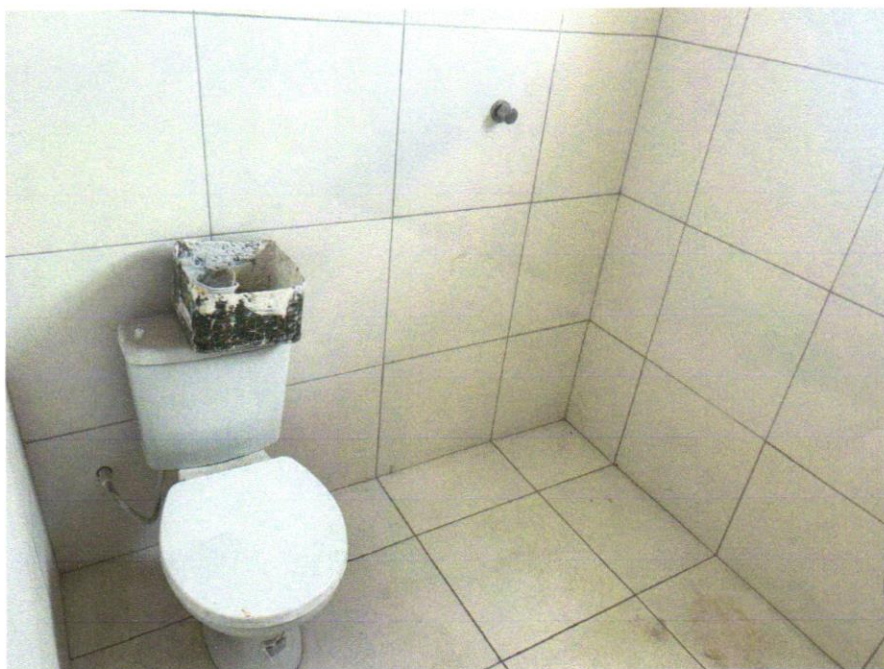
Foto 16 - VASO SANITARIO SIFONADO CONVENCIONAL COM LOUÇA BRANCA - FORNECIMENTO E INSTALAÇÃO. AF_01/2020
