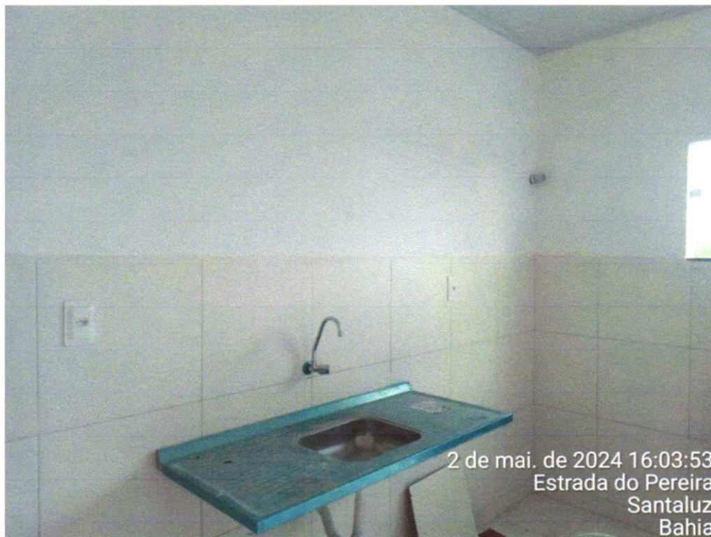
Foto 25 - Pia de cozinha com bancada em aço inox, dim 1,20x0,60m c/ 01 cuba, válvula cromada, sifão cromado e torneira cromada, concretada e assentada. Rev.04
