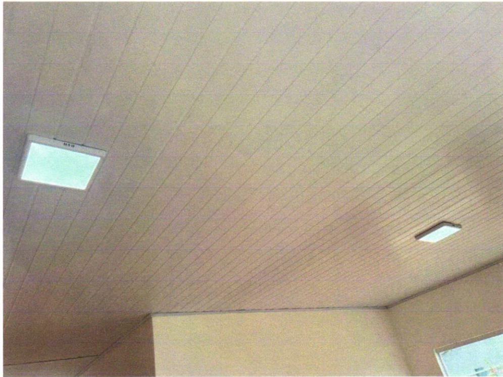
Foto 11 - Forro de pvc, em réguas de 10 ou 20 cm, aplicado, inclusive estrutura para fixação (perfis em PVC) marca Araforros ou similar, instalado - Rev 06_10/2021
