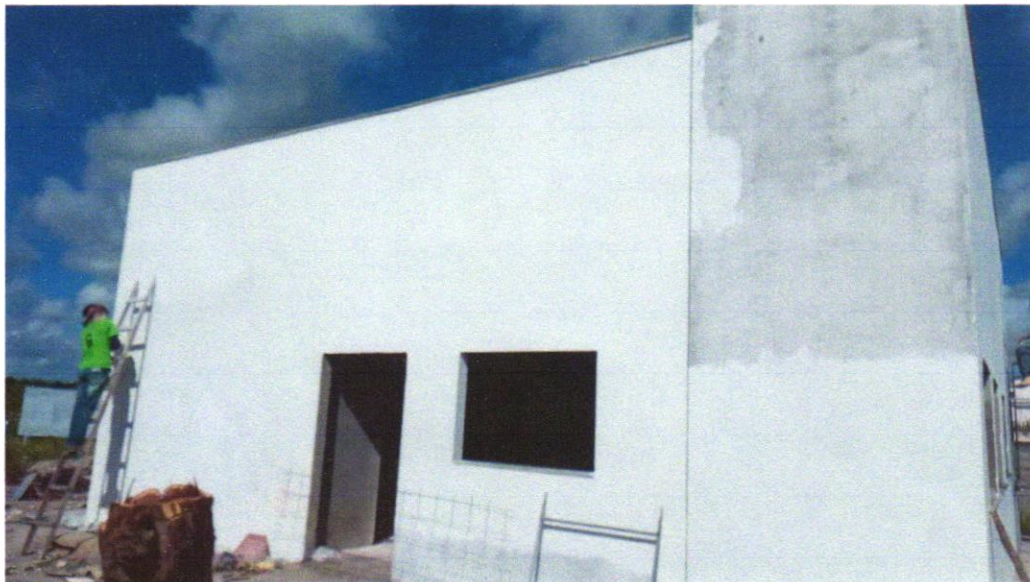
Foto 05- APLICAÇÃO E LIXAMENTO DE MASSA LÁTEX EM PAREDES, UMA DEMÃO. AF_06/2014
