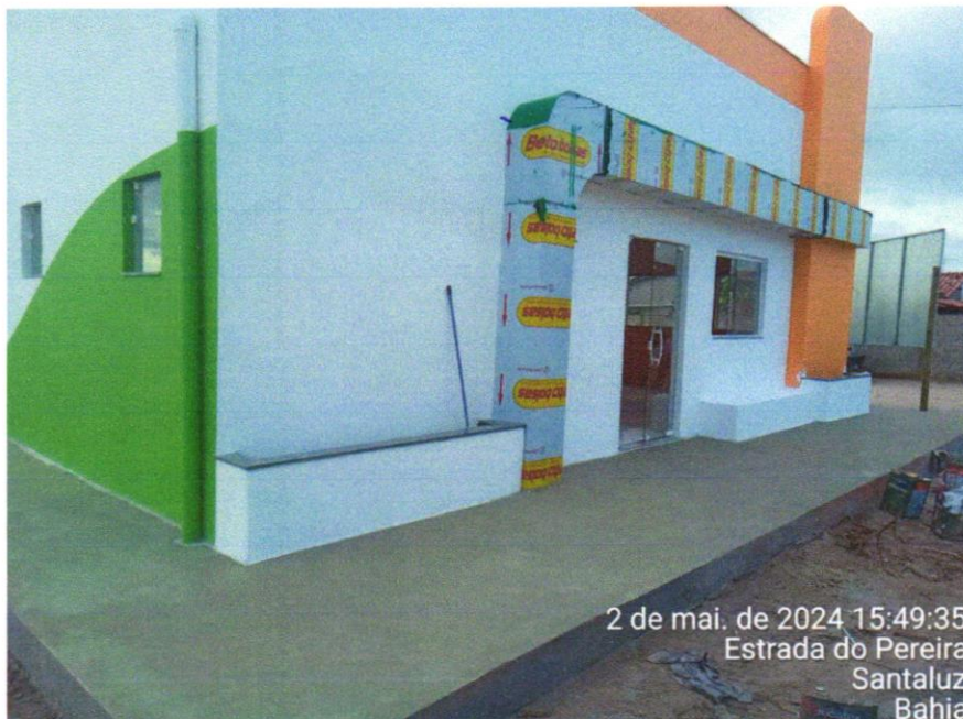
Foto 02 – Revestimento metálico em alumínio composto (Alucobond), e=0,3mm, pintura Kaynar 500 composta por seis camadas, inclusive estrutura metálica auxiliar em perfil de viga "U" de 2" - fornecimento e montagem
