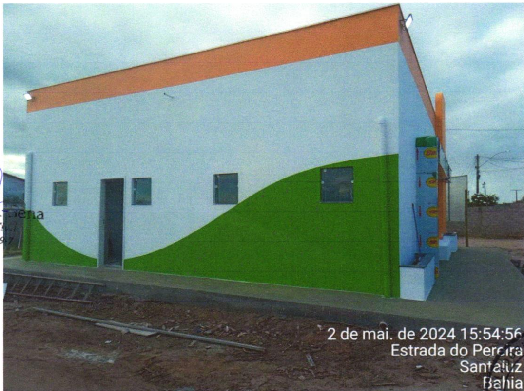
Foto 06 - APLICAÇÃO MANUAL DE PINTURA COM TINTA LÁTEX ACRÍLICA EM PAREDES, DUAS DEMÃOS. AF_06/2014
