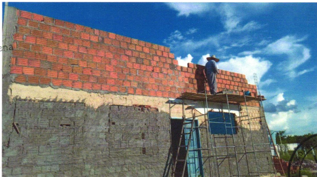
Foto 20 - ALVENARIA DE VEDAÇÃO DE BLOCOS CERÂMICOS FURADOS NA HORIZONTAL DE 9X19X29 CM (ESPESSURA 9 CM) E ARGAMASSA DE ASSENTAMENTO COM PREPARO EM BETONEIRA. AF_12/2021
