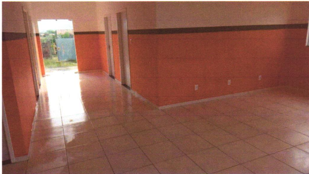
Foto 07 - APLICAÇÃO MANUAL DE PINTURA COM TINTA LÁTEX ACRÍLICA EM PAREDES, DUAS DEMÃOS. AF_06/2014
