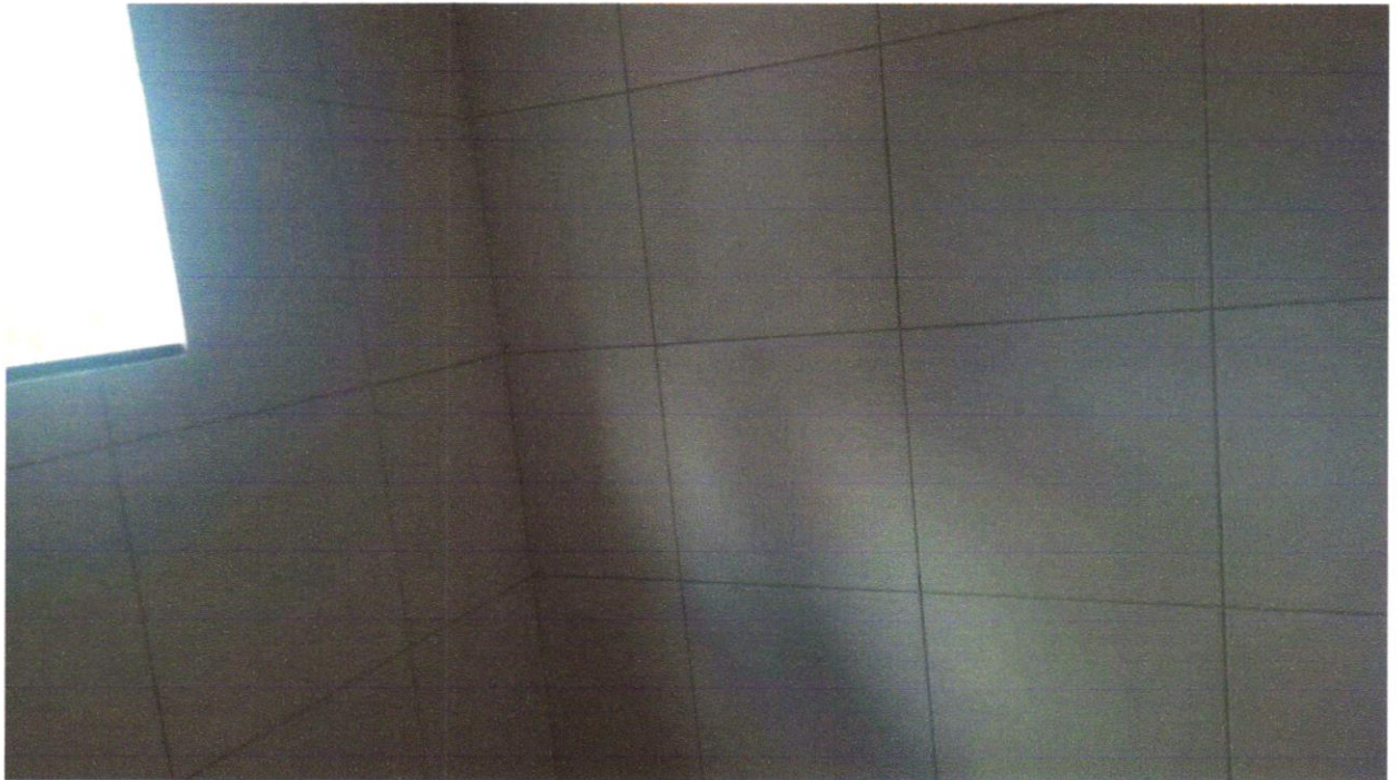
Foto 27 - REVESTIMENTO CERÂMICO PARA PISO COM PLACAS TIPO ESMALTADA EXTRA DE DIMENSÕES 45X45 CM APLICADA EM AMBIENTES DE ÁREA MAIOR QUE 10 M2. AF_06/2014
