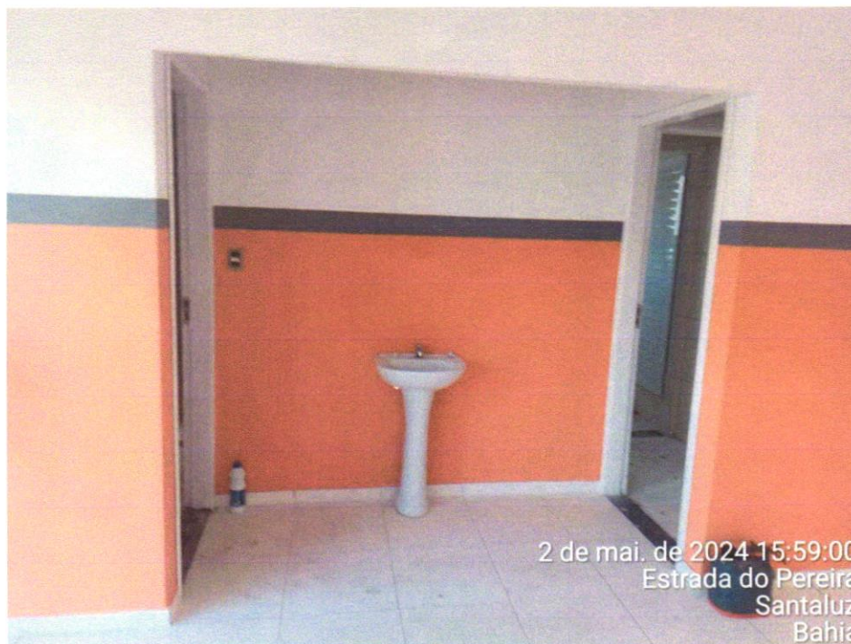
Foto 15 - LAVATÓRIO LOUÇA BRANCA COM COLUNA, 45 X 55CM OU EQUIVALENTE, PADRÃO MÉDIO - FORNECIMENTO E INSTALAÇÃO. AF_01/2020
